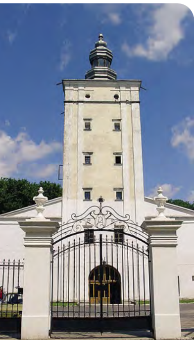
Wieża bramna w zespole zamkowym Radziwiłłów
